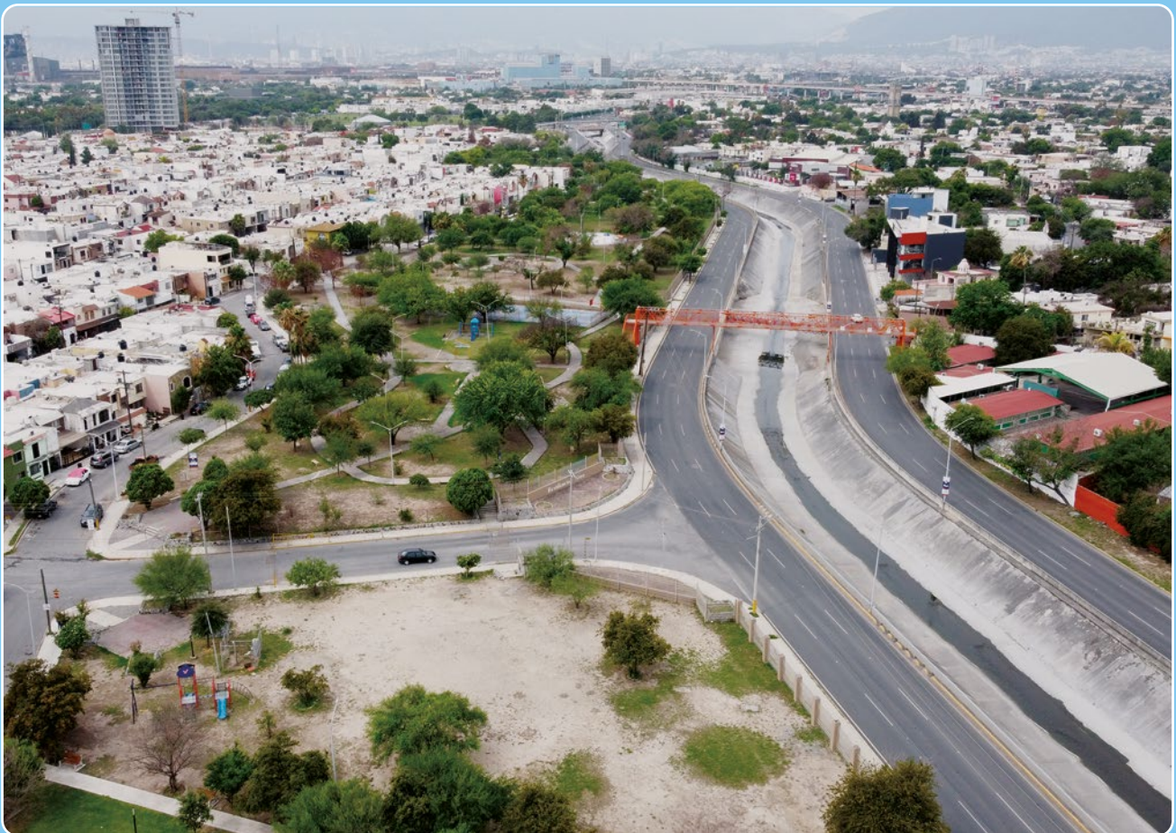
Estado actual Arroyo Topo Chico en San Nicolás de los Garza.
